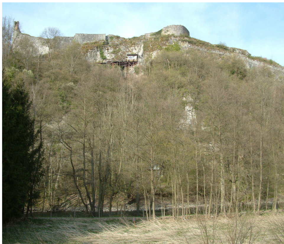
▼ Fig. 4 : localisation du chantier à flanc de coteau en avril 2003 (cl. B. W.)
