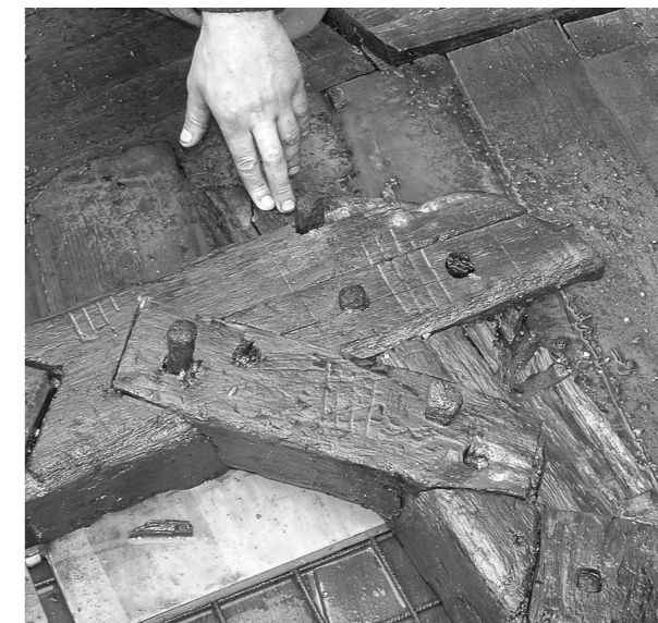
▲ Fig. 19 : détail de la roue et de ses marques d'assemblage (cl. B. W.)
